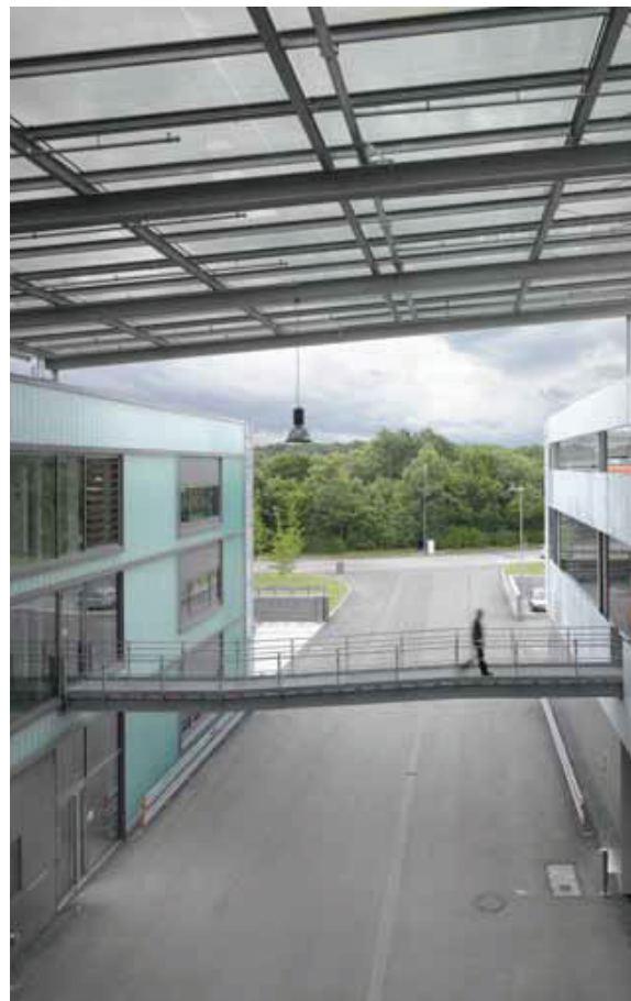
Die Magistrale dient dem Be- und Entladen und wird mit einem PV-Dach vor Niederschlag geschützt
