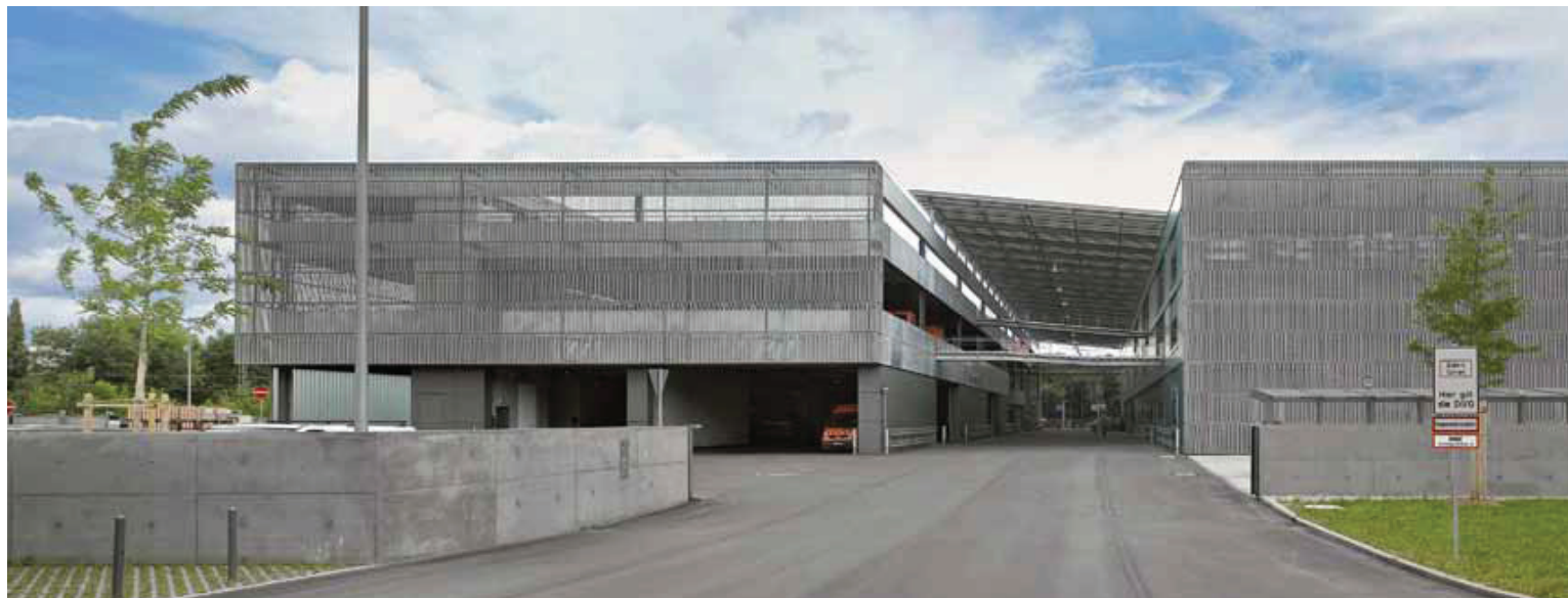
Der kalte (links) und der warme (rechts) Gebäuderiegel werden durch eine netzartige Hülle aus Streckmetall zusammengefasst
