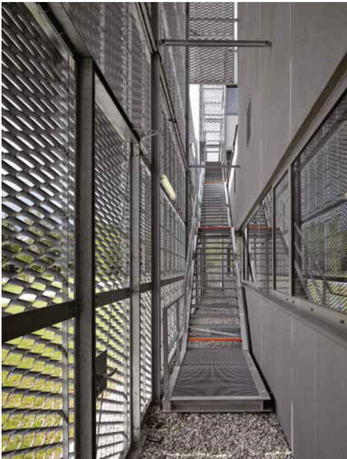
Die Fluchttreppen wurden an der Außenwand hinter der Streckmetallfassade kaskadenförmig angeordnet
